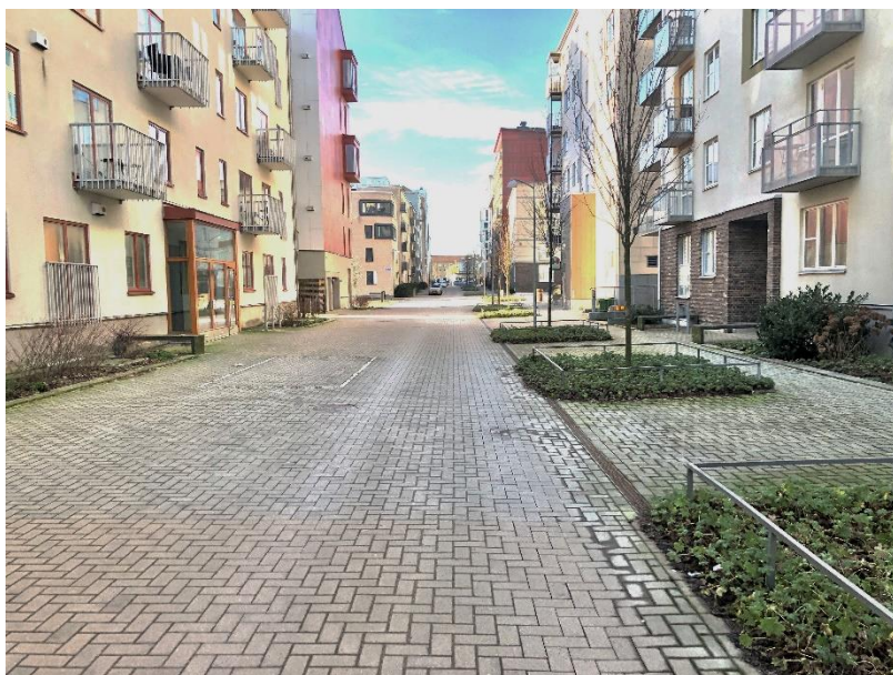
Figur 30: Exempel lågfartsgata i Kvillebäck med markbeläggning av betongmarksten utan nivåskillnader och planteringar med träd.
